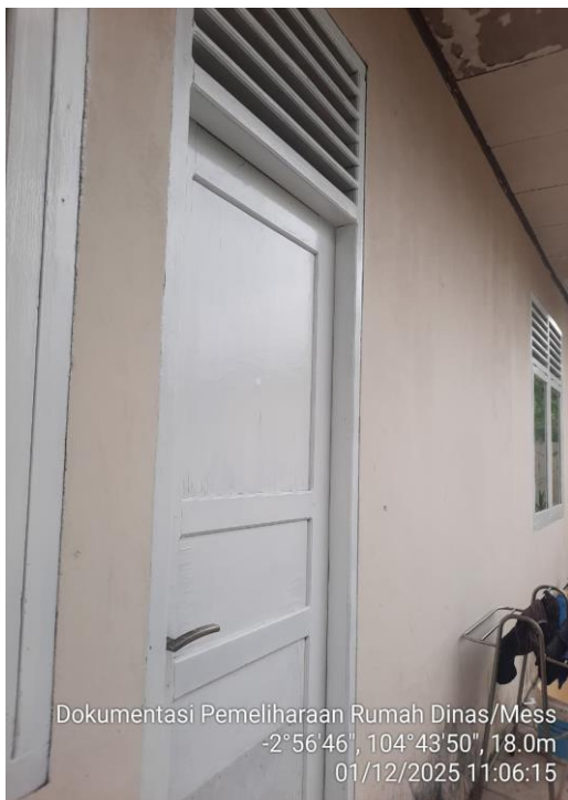
Pengecatan cat kusen pintu satu daun
