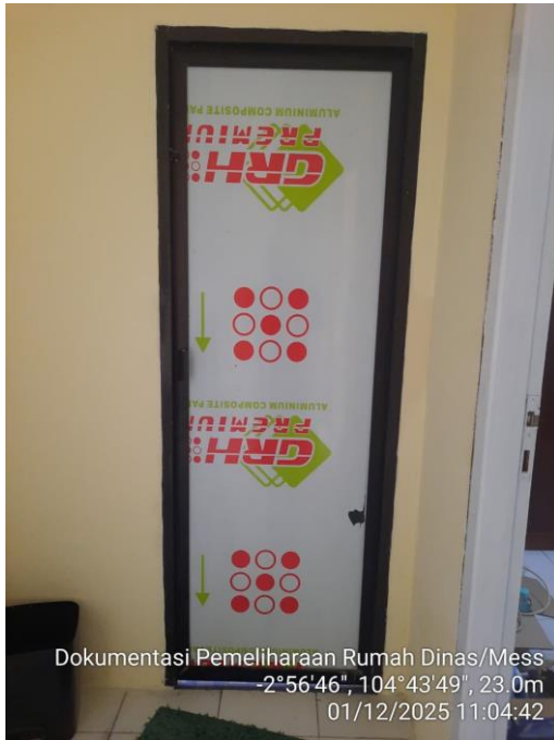
Pekerjaan Pengecatan cat boyvenli WC
