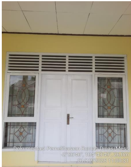
Pengecatan cat kusen pintu dua daun
