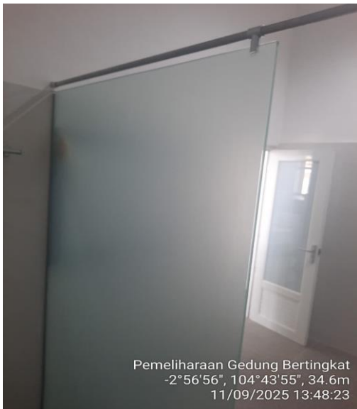
Pengerjaan Partisi Dinding Kaca Toilet
