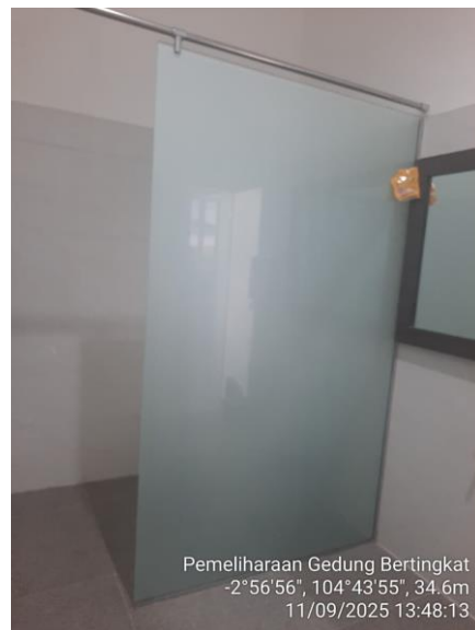
Pengerjaan Partisi Dinding Kaca Toilet
