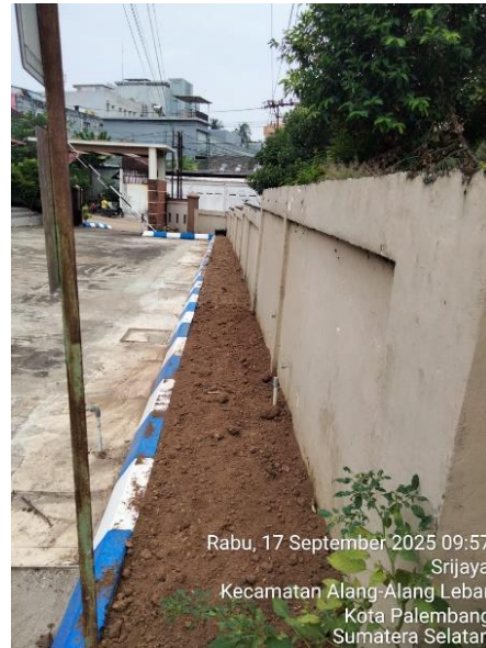
Penutupan saluran air, dan penimbunan tanah untuk taman kantor
