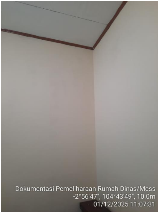
Pekerjaan Pengecatan dinding dalam
