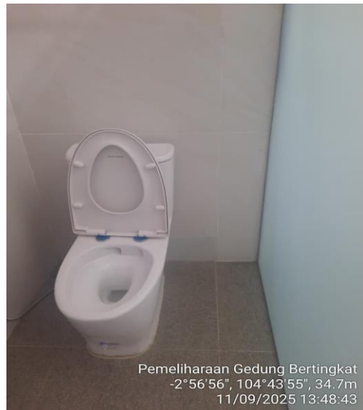
Pengerjaan Partisi Dinding Kaca Toilet
