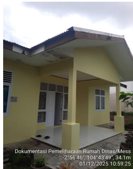
Pekerjaan Pengecatan dinding luar
