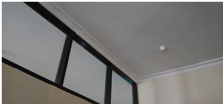
Kondisi Setelah Pemeliharaan atap
