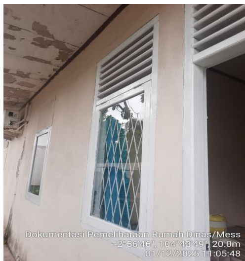
Pengecatan kusen dan jendela satu daun
