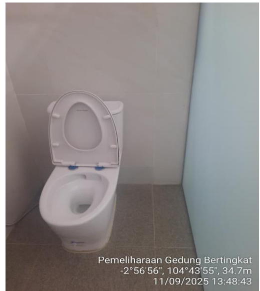
Pengerjaan Partisi Dinding Kaca Toilet
