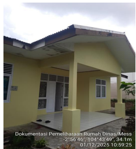
Pekerjaan Pengecatan dinding luar
