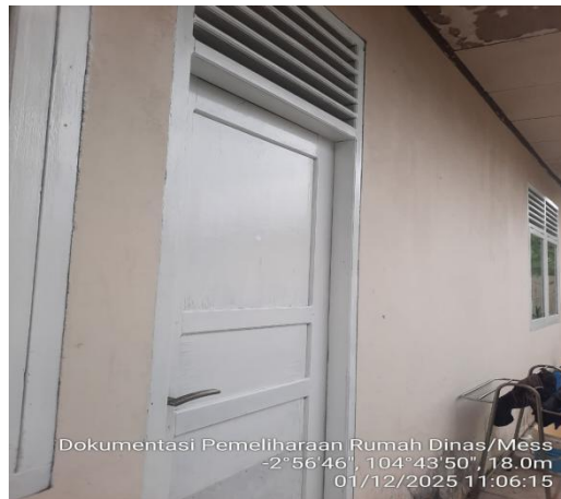
Pengecatan cat kusen pintu satu daun
