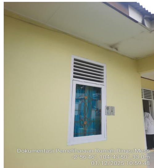
Pengecatan kusen dan jendela satu daun
