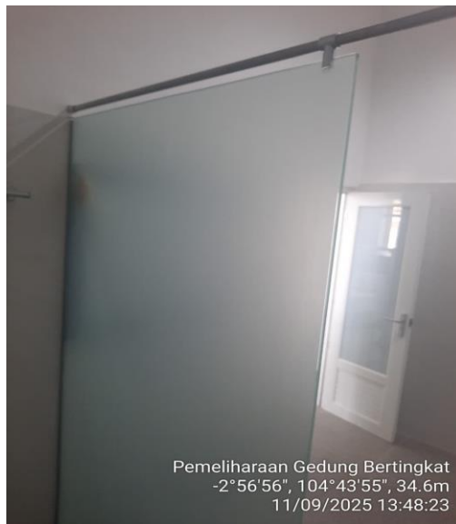
Pengerjaan Partisi Dinding Kaca Toilet
