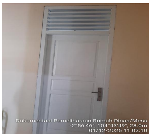
Pengecatan cat kusen pintu satu daun
