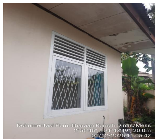
Pengecatan kusen dan jendela dua daun
