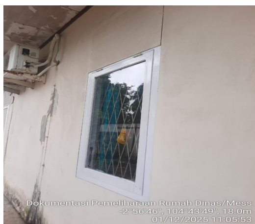
Pengecatan kusen dan jendela satu daun
