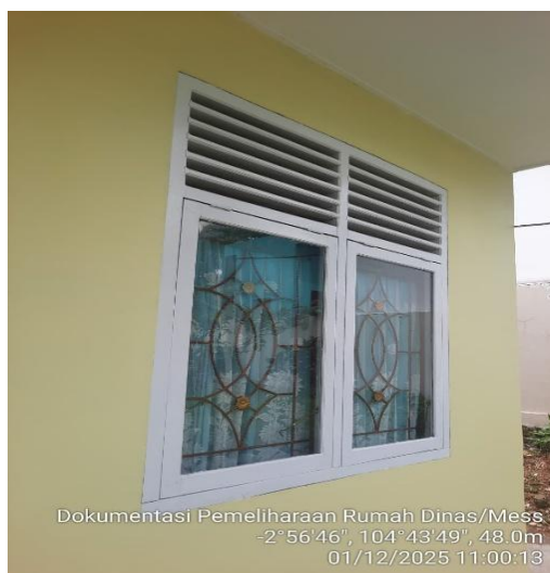
Pengecatan kusen dan jendela dua daun
