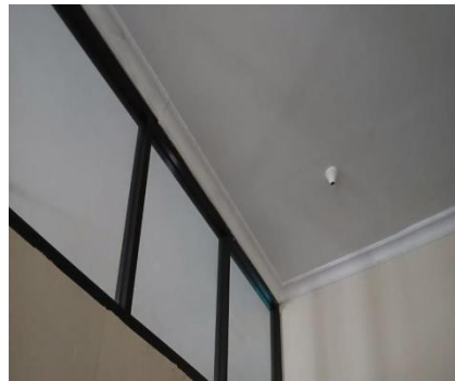
Kondisi Setelah Pemeliharaan atap
