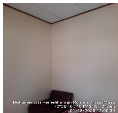
Pekerjaan Pengecatan dinding dalam
