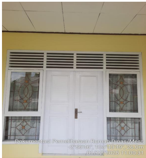
Pengecatan cat kusen pintu dua daun
