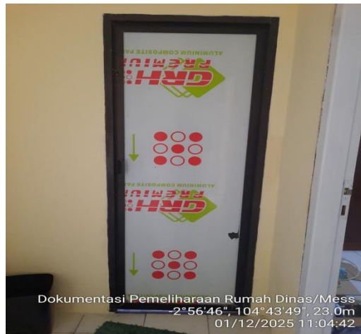
Pekerjaan Pengecatan cat Boyvenli WC
